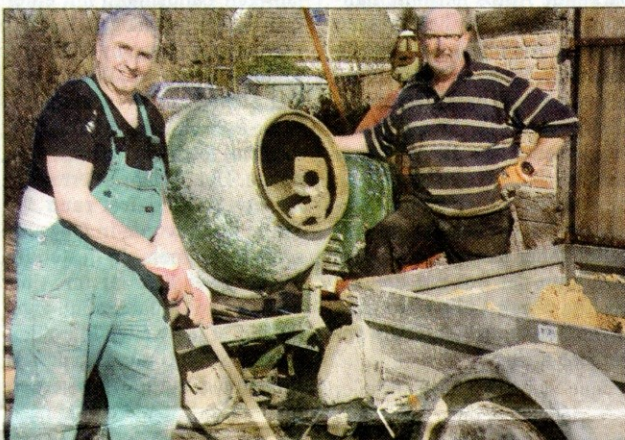
„Wir brauchen ein Fundament für unseren neuen Nagelbaum!“ Werner Bauer (links) und Heinz-Dieter von Plata arbeiten an der Betonmischmaschine.
