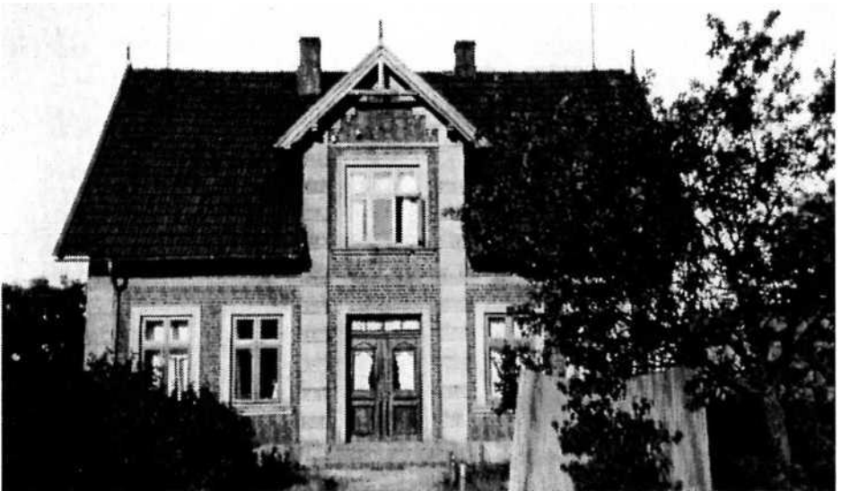
Das Schweenske Haus 1909. Es wurde 2000 abgerissen.
